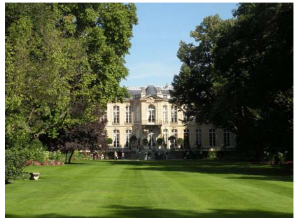
Hôtel de Matignon (résidence du Premier ministre), façade côté jardin.
