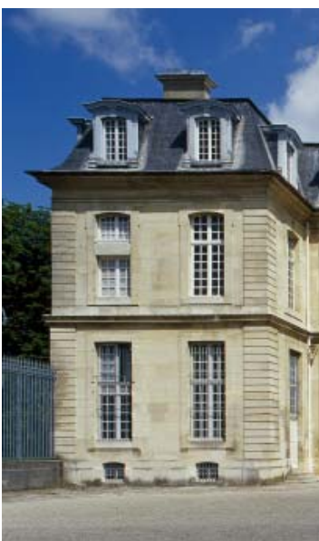
Avant-corps latéral ouest, côté cour
