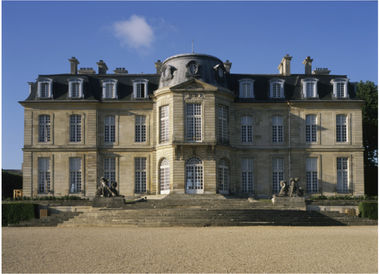
Façade du château de Champs-sur-Marne, côté jardin
