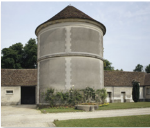
Pigeonnier et autres bâtiments de la ferme
